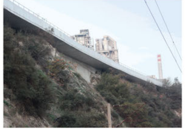
Hereke-Batı Kavşağı Konsol Yol Çalışması / Hereke-West Interchange Cantilever Road Platform.
