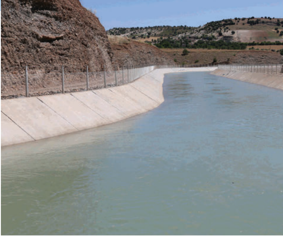
Regülatör ve Çökeltim Havuzu / Regulator & Settling Basin
