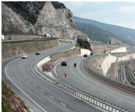
D-100 Devlet Yolu Şirinyalı Mevkii Anayol Çalışması / D-100 Motorway Sirinyali Main Road Works
