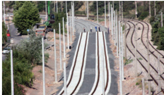
Travers ve ray çalışması / Rail and slipper works
