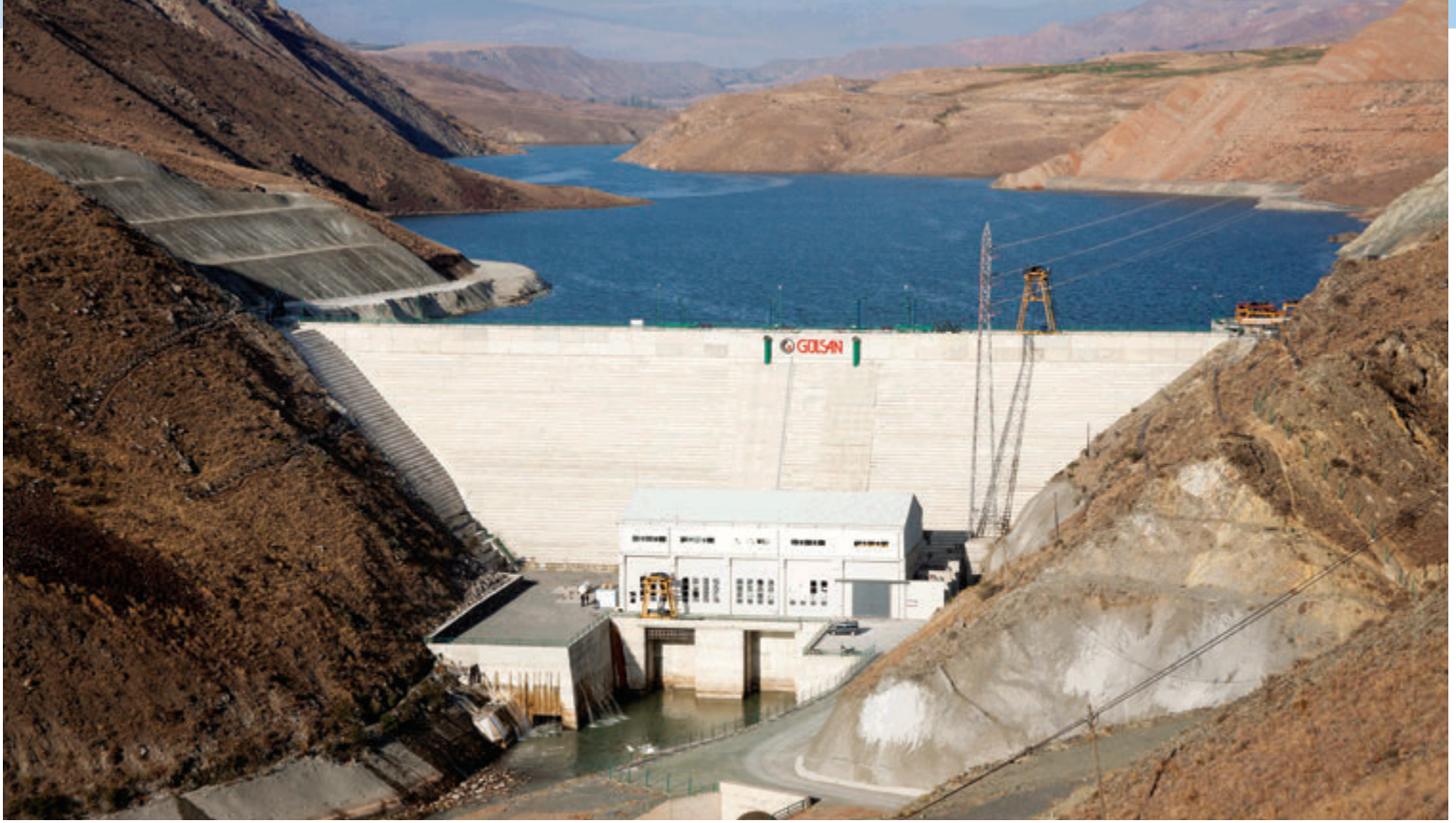
Sefaköy HES Derivasyon – Dolusavak Tünelleri ve Enerji Kırıcı Havuz / Sefaköy HPP Diversion – Spillway Tunnels and Hydraulic Jump Stilling Basin
