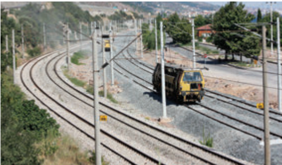
Buraj Yapımı / Tamping
