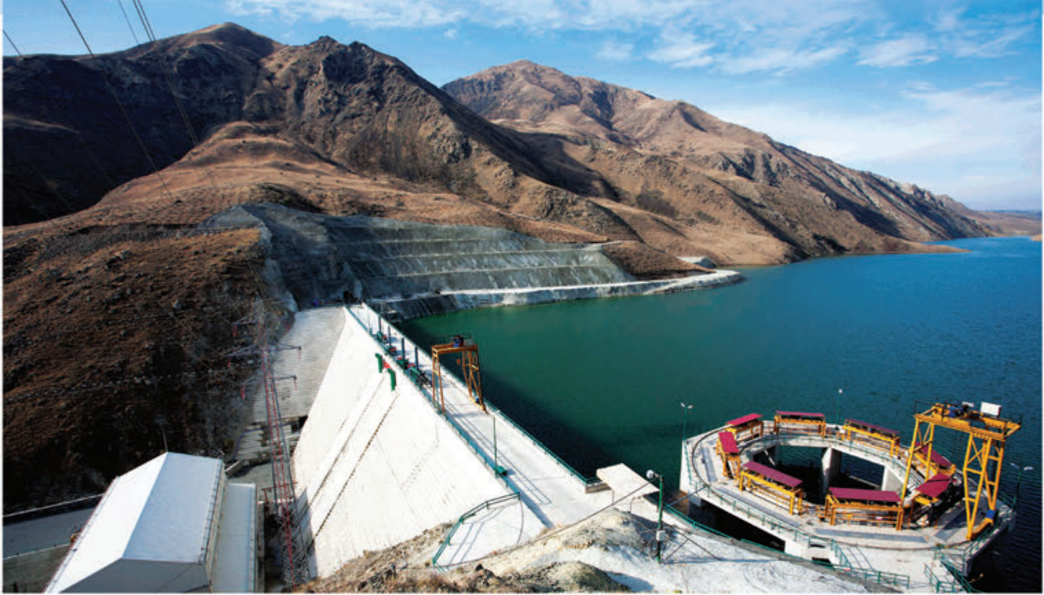
Santral Binası, Baraj Gövdesi ve Dolusavak Şaftı / Power House, Body of Dam & Spillway Shaft
