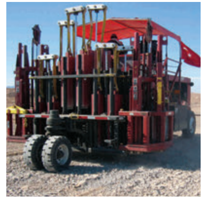
Beton Yol Kırılması İşi / Rigid Pavement Rubberizing
