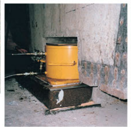
Depremde zarar gören Sakarya Viyadüğü Onarımı Rehabilitation of earthquake damaged Sakarya Viaduct
