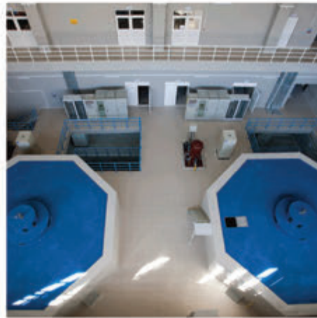
Santral Binası / Power House
