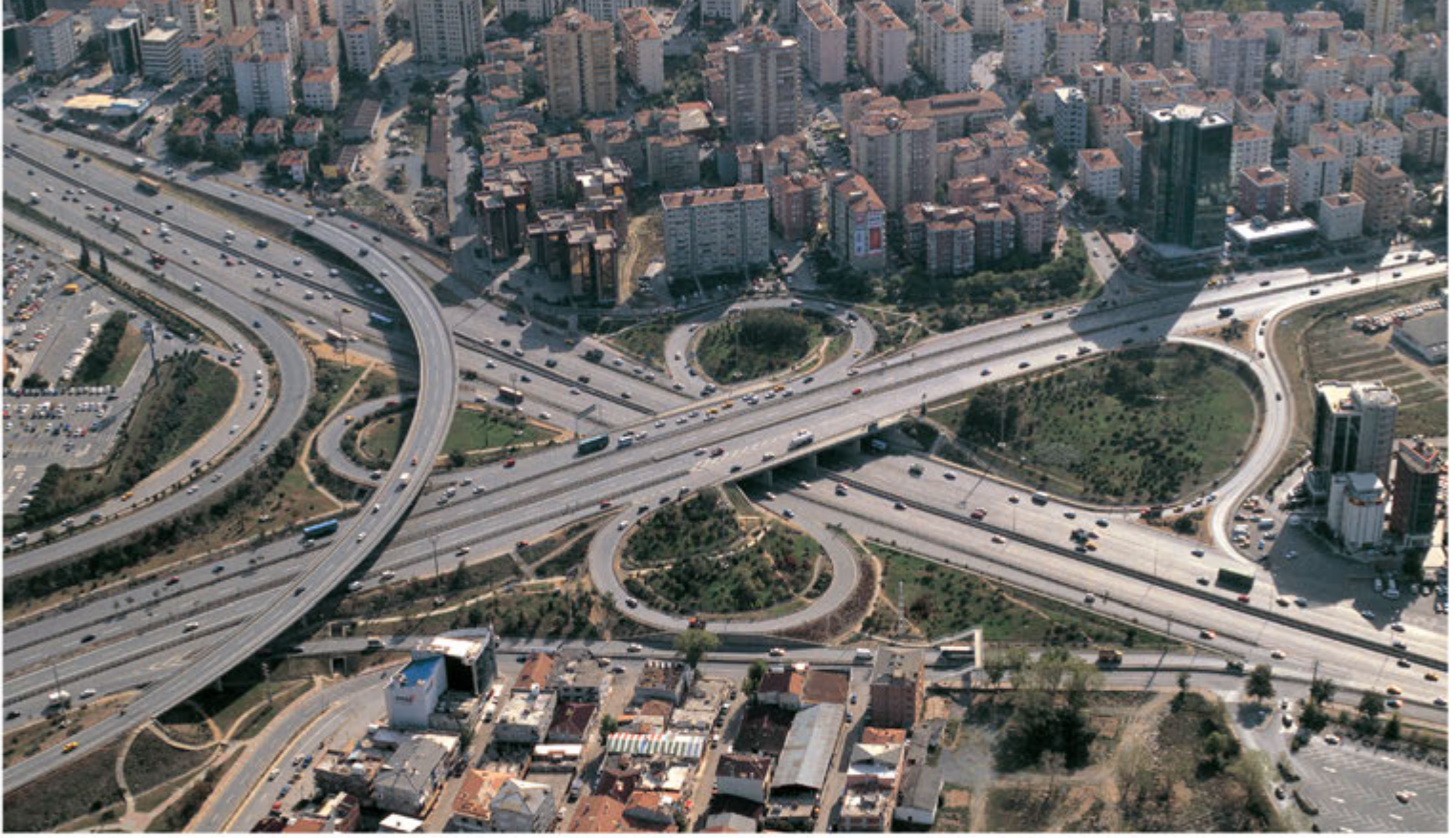
D-100 Devlet Yolu Kozyatağı Kavşağı-İstanbul / D-100 Motorway Kozyatagi Interchange-Istanbul
