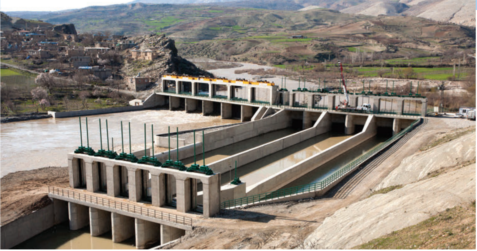
Regülatör ve Çökeltim Havuzu Genel Görünüm / Regulator & Settling Basin General View
