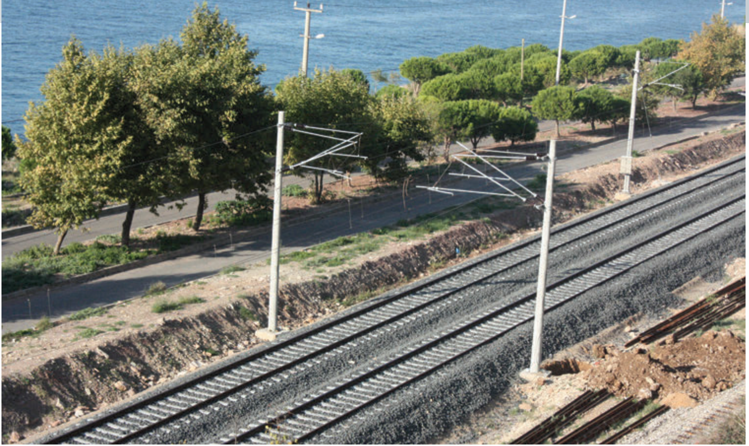
D-100 Devlet Yolu Gebze-İzmit kesiminde TCDD Demiryolu Yapım İşi / Railway Construction of TCDD on D-100 Motorway Gebze-İzmit Section
