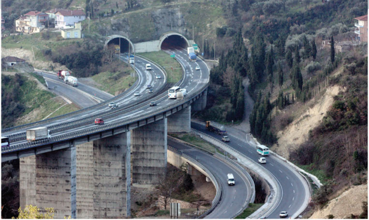
Hereke Doğu Kavşağı Anayol Çalışmaları / Hereke East Interchange Main Road Works
