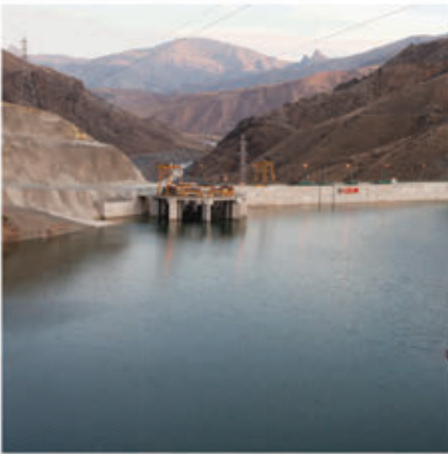
Baraj Gölü ve Dolusavak Şaft Genel Görünümü / Reservoir & Spillway Shaft General View
