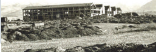
Malatya E-Tipi Cezaevi İnşaatı - 1979
