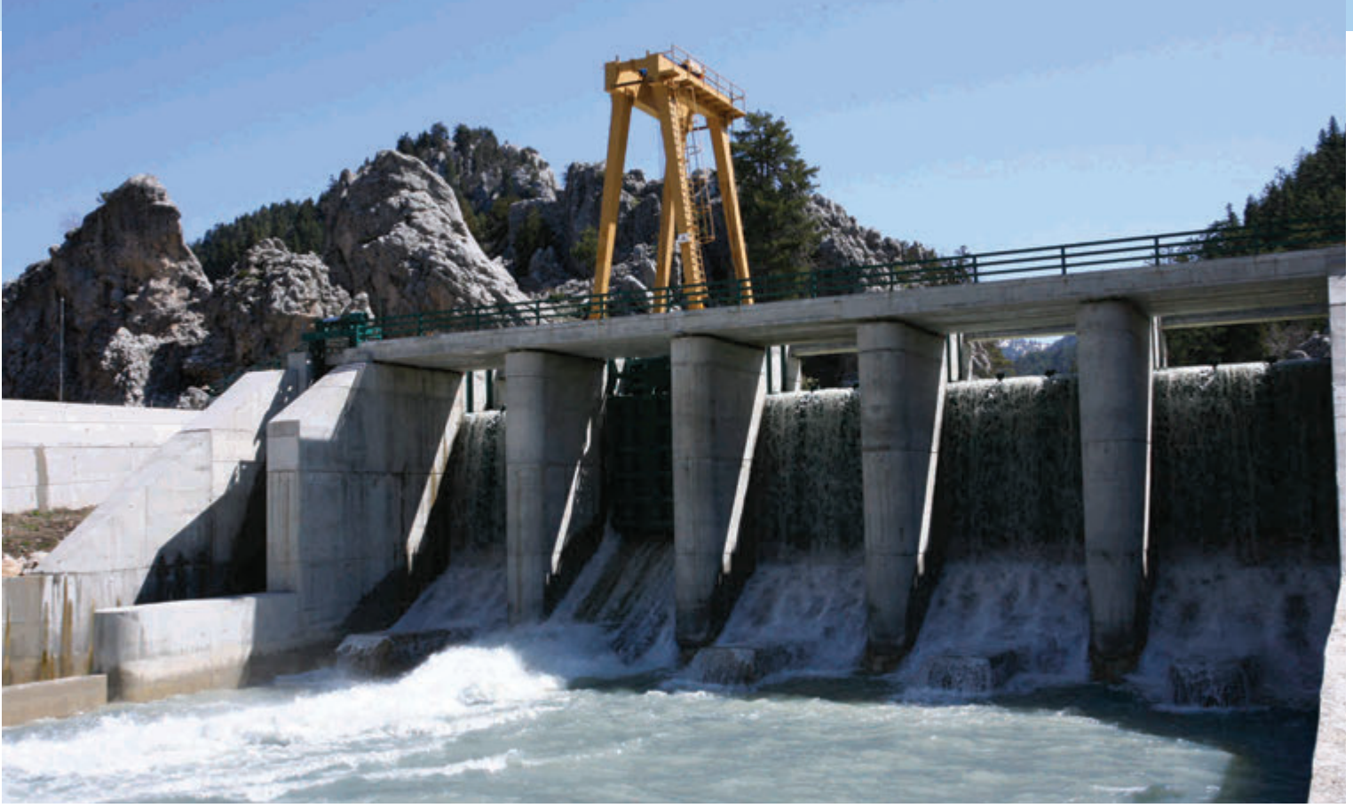
Değirmenüstü HES Regülatör ve Dolusavak / Degirmenustu HPP Regulator and Spillway
