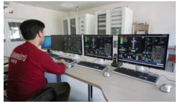
Kontrol Merkezi / Control Center
