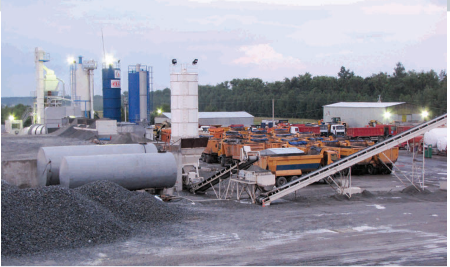
Kiev-Chop km 128-182 Otoyolu Yapım İşi Şantiye Tesisleri / Kiev-Chop km 128-182 Highway Construction Camp Site
