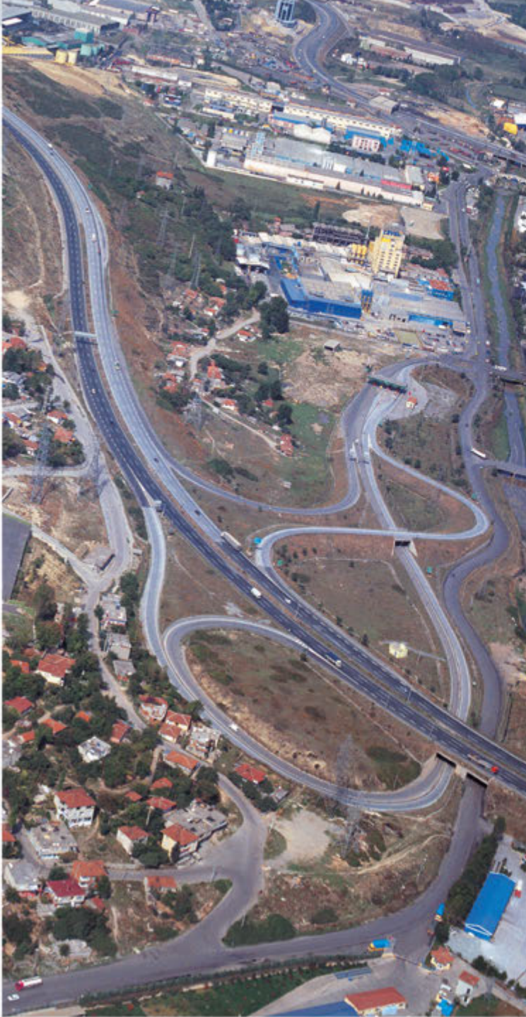
Gebze-İzmit Otoyolu Dilovası Kavşağı / Gebze-Izmit Motorway Dilovasi Interchange
