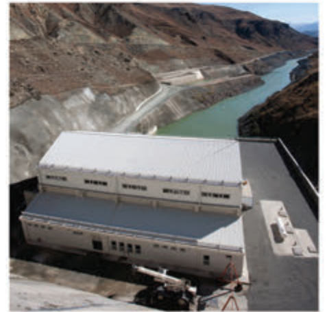
Santral Binası/ Power House
