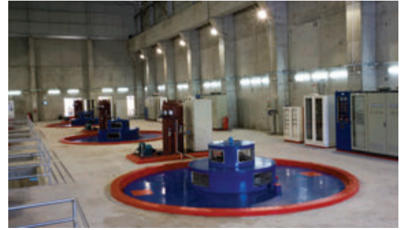
Santral Binası / Power House
