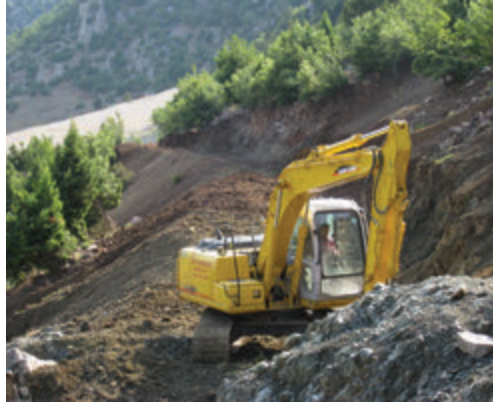
Servis Yolları Yapımı Construction of Service Roads
