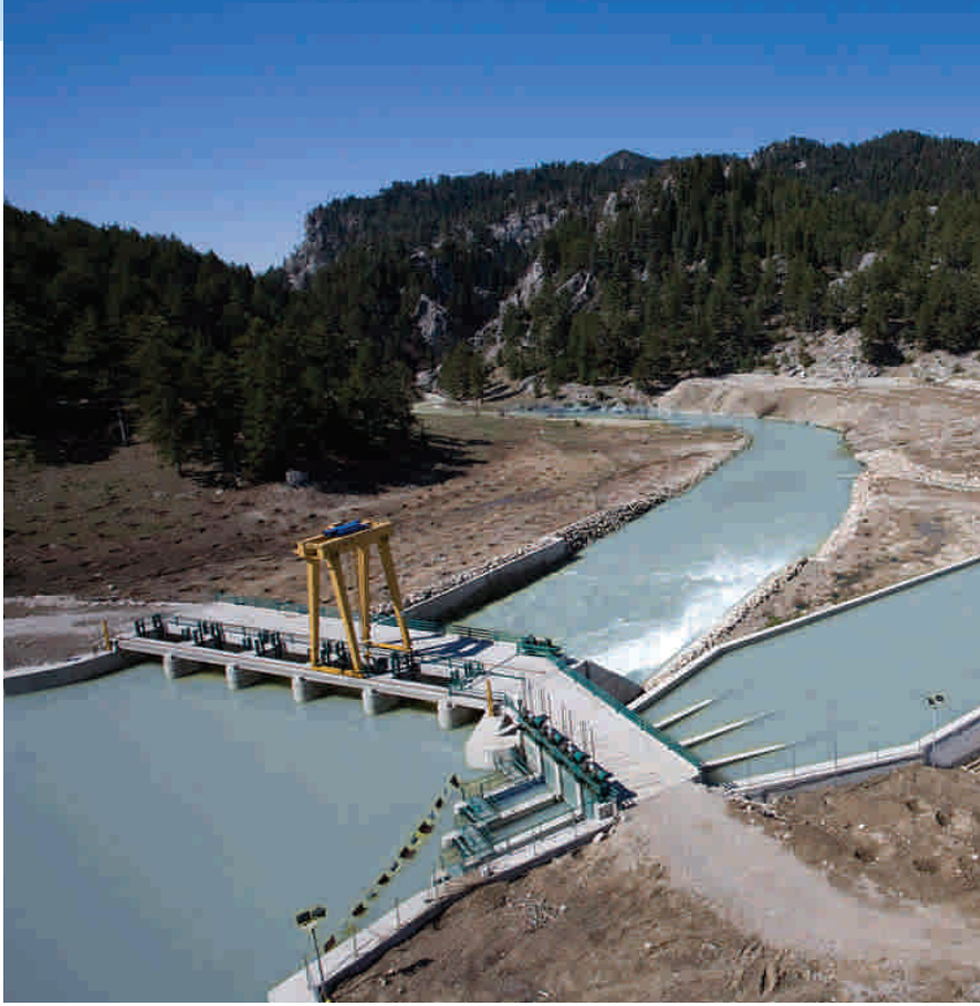
Regülatör, Dolusavak, Çökeltim Havuzu / Regulator, Spillway, Settling Basin
