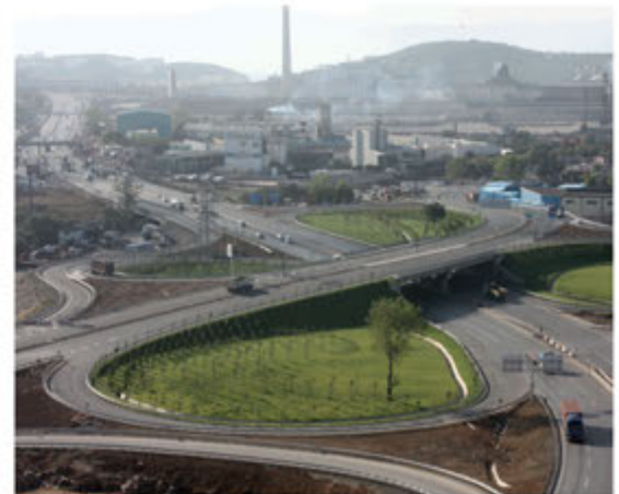
D-100 Devlet Yolu Dilovası Kavşağı / D-100 Motorway Dilovasi Interchange
