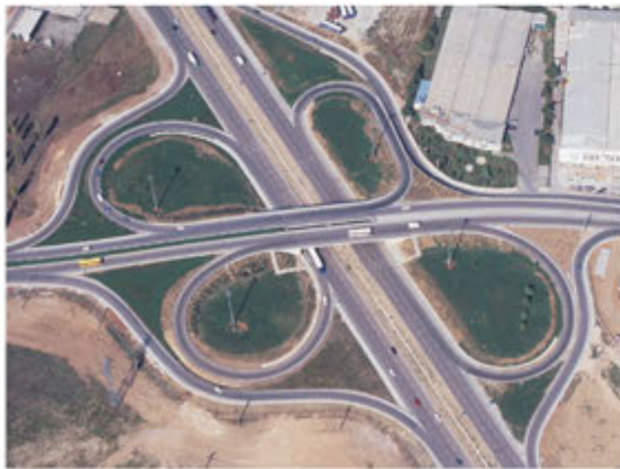
Bursa Çevre Otoyolu Demirtaş Kavşağı / Bursa Peripheral Motorway, Demirtaş Interchange
